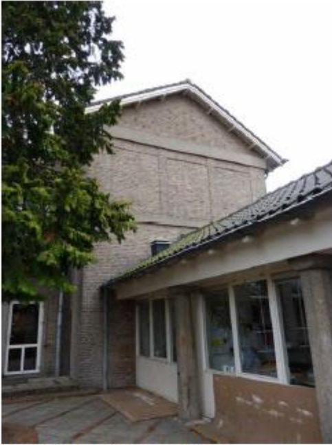
Eenlaags volume onder zadeldak
