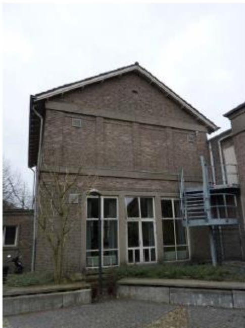
Achtergevel (kleine volume tegen kopgevel oostelijke vleugel)
