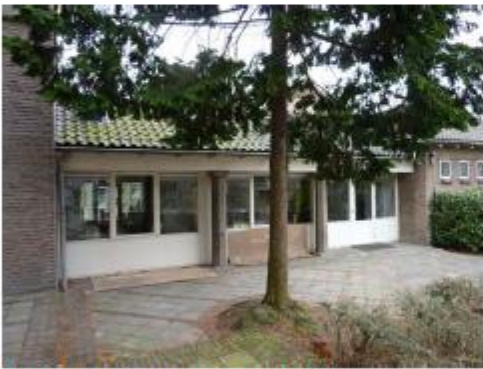
Eenlaags volume onder zadeldak
