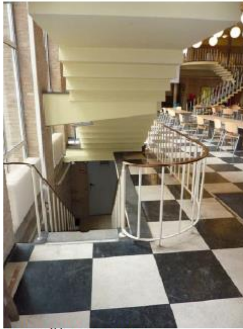
Trappartij in centrale hal
