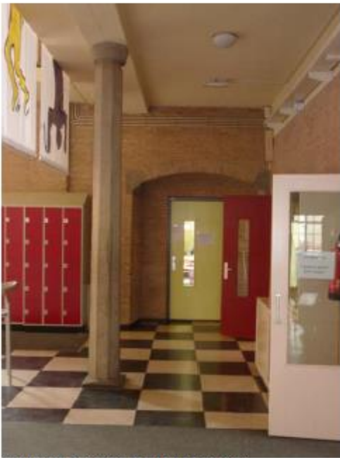
Centrale hal met dragende kolom
