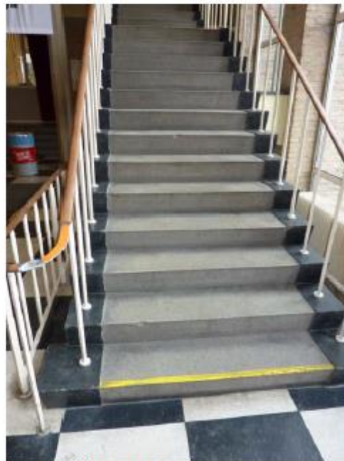
Trappartij in centrale hal
