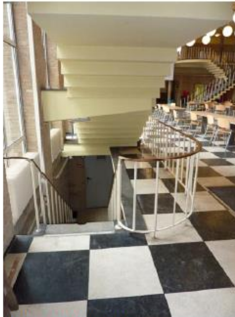
Trappartij in centrale hal
