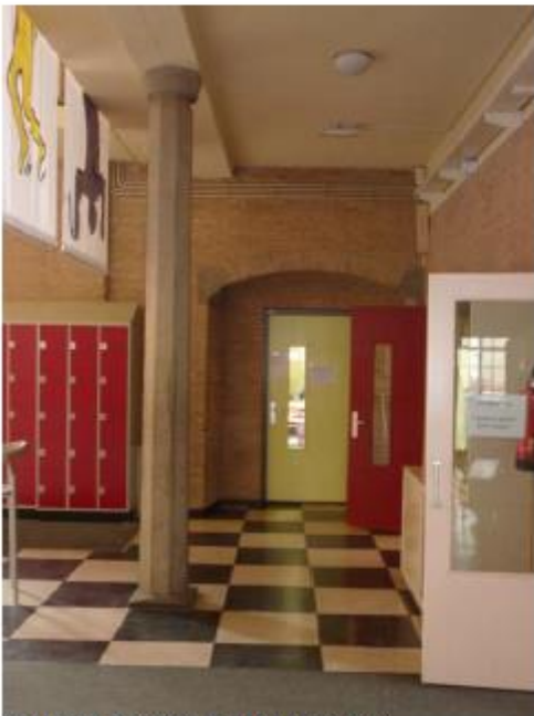
Centrale hal met dragende kolom
