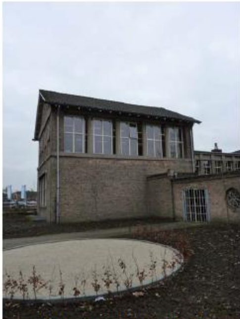
Rechter zijgevel (kleine volume tegen kopgevel oostelijke vleugel)
